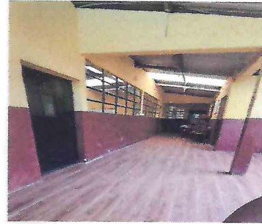
FOTO NO. 2 PISO CERAMICO
