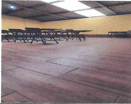
FOTO NO.1 NIVELACION DE PISO
