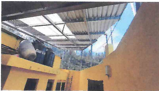
FOTO NO 4 TECHO AREA DE BAÑOS Y PATIO
